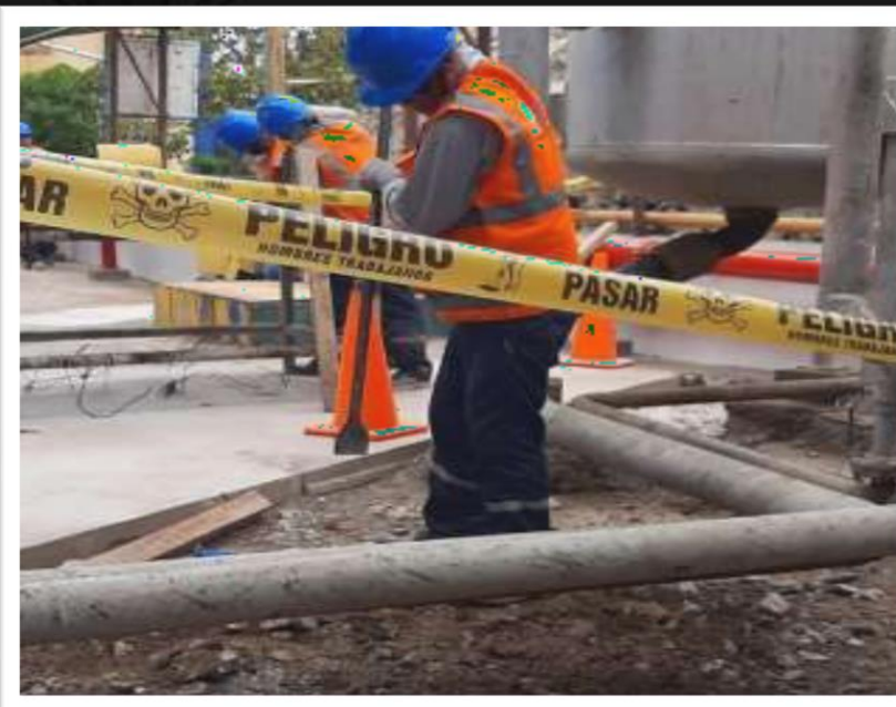
Obras Complementarias para Infraestructura
