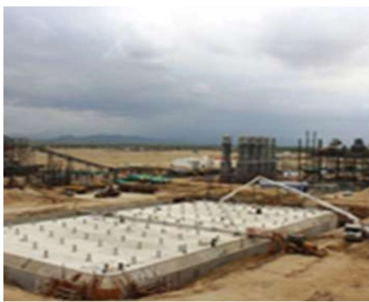
Fabricación de mallas de Sistema de Protección de Puesta a Tierra, soldadura exotérmica y mediciones de resistencia
