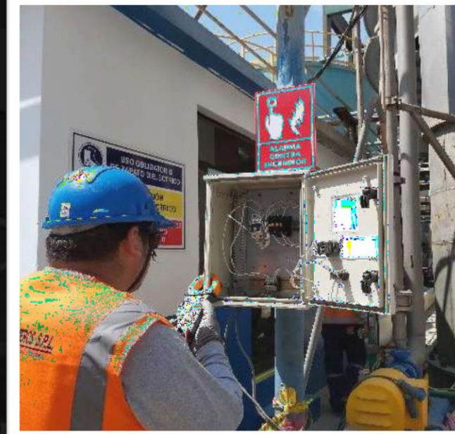
Reparación & Mantenimiento Del Sistema de canalización Eléctrica
