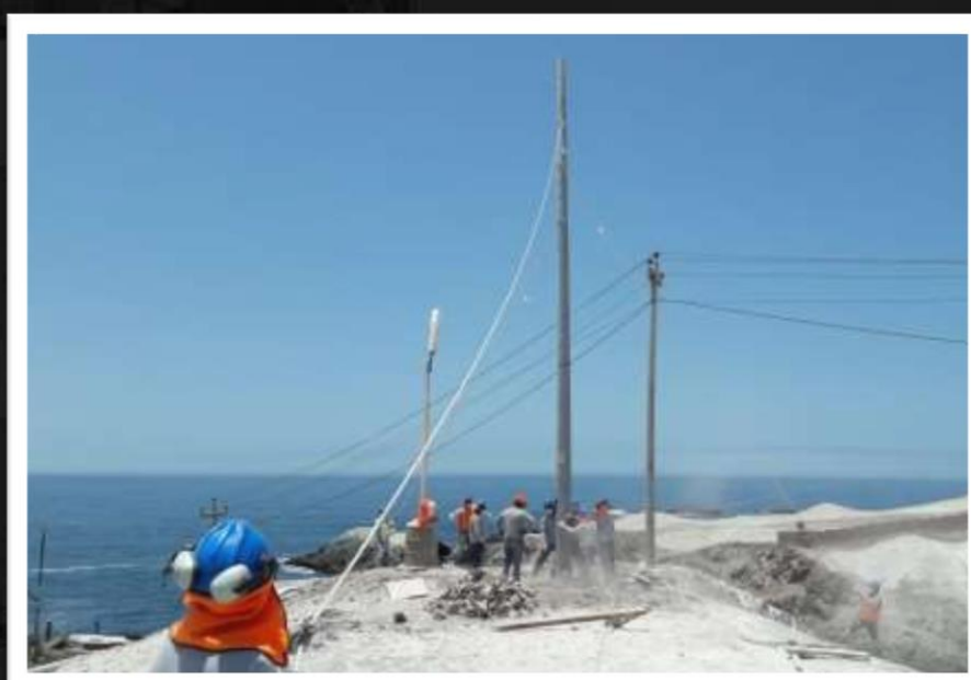
Instalación de redes aéreas en sistemas de utilización media tensión de TASA
