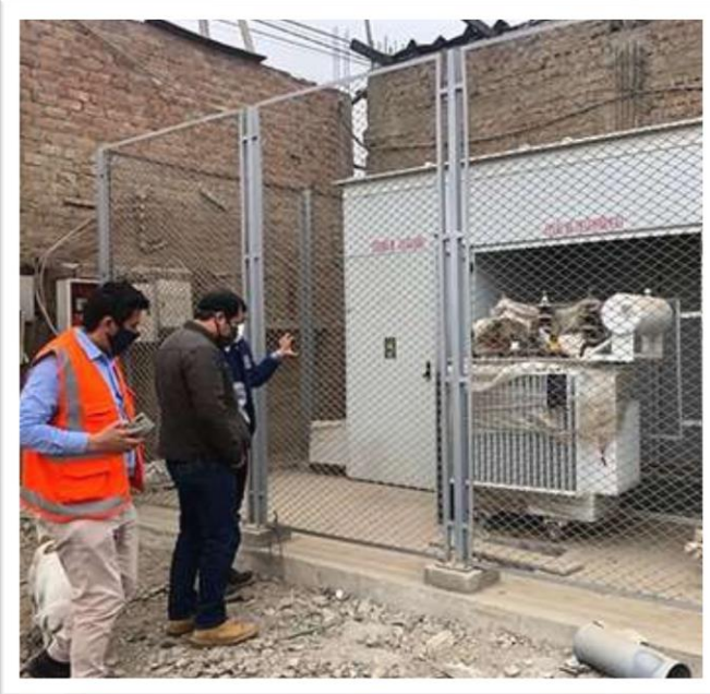
Ejecución de Sistema de utilización en media tensión 20 kv
