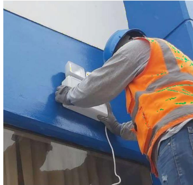
Instalación y Montaje del Sistema Luces de Emergencia
