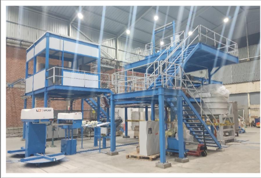
Suministro y montaje de nueva planta de lamina y cable de cobre Planta Industrial de CELSA Ate Viatrte - Lima
