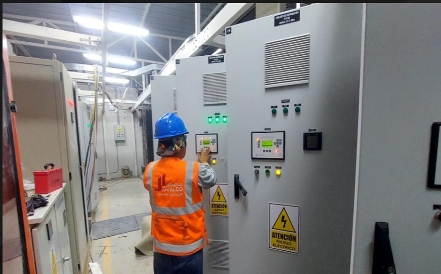
Instalación y puesta en marcha de tablero de sincronismo
