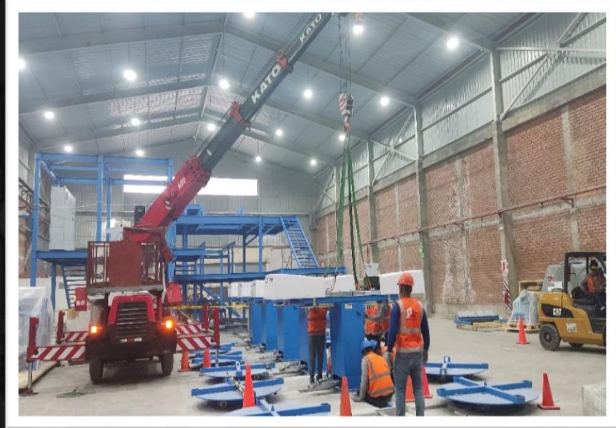
Montaje total de equipos de producción Planta Industrial CELSA Ate Vitarte - Lima
