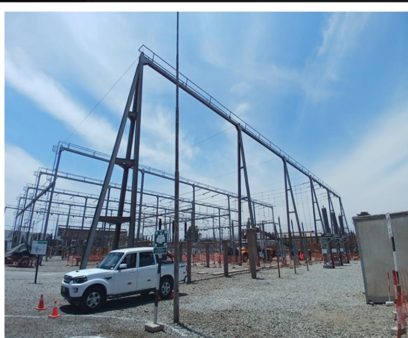
Piezas de apoyo para pórticos en SET - BARSÍ Trabajo de apoyo de emergencia Pluz Energia - Callao
