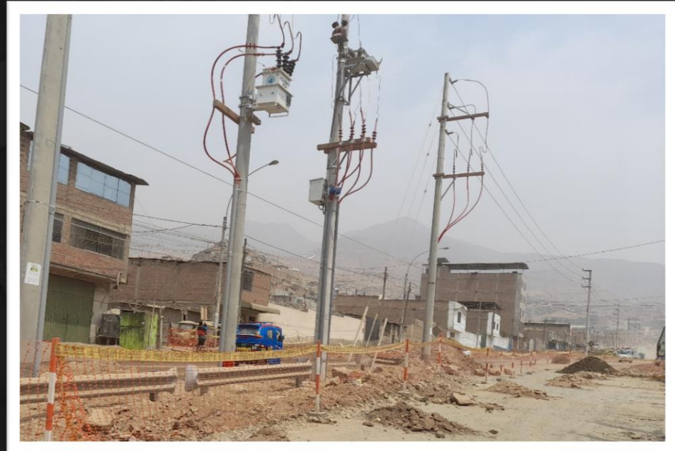
Diseño e instalación de subestación eléctrica – 22.9 KV
