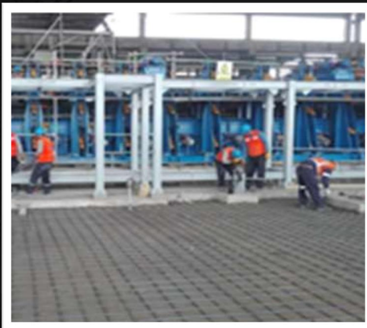
Instalaciones eléctricas de fuerza y control en planta de producción APH
